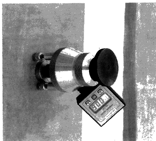
Figura 2.- Ensayo para la determinación de la adherencia in situ. Figure 2.- In situ pull-out test.
