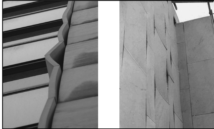
Figura 1. Dilatación con resultado de combadura cóncava y convexa de los paneles de mármol. Figure 1. Expansion-mediated concave and convex bowing of marble panels.
