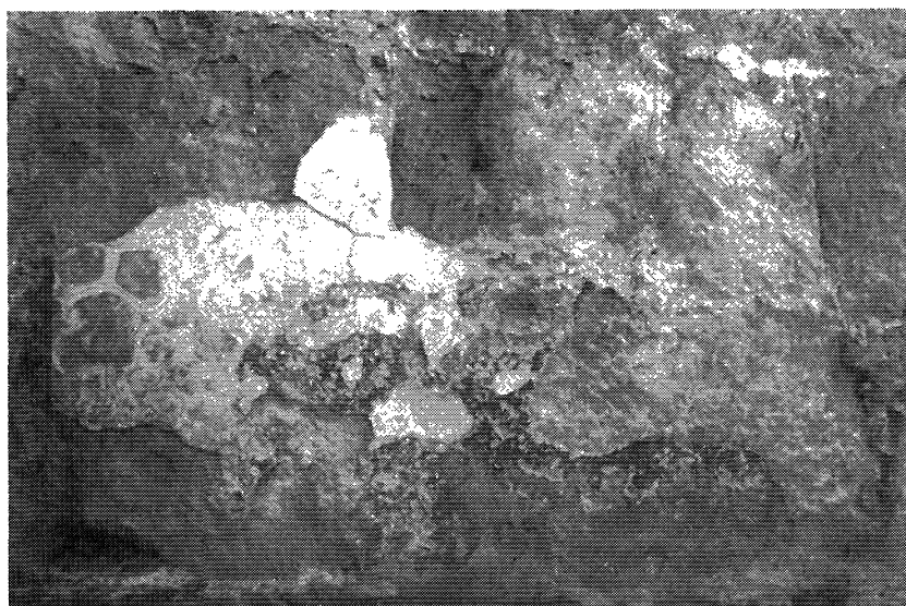
Fig. 2.- Dar al Yund. Restos de morteros originales y de reparación.
