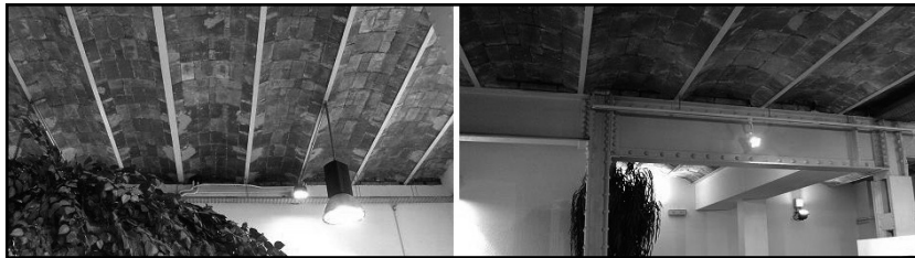
Figura 1. Vista inferior típica de los forjados estudiados. Figure 1. Typical bottom view of the slabs studied.
