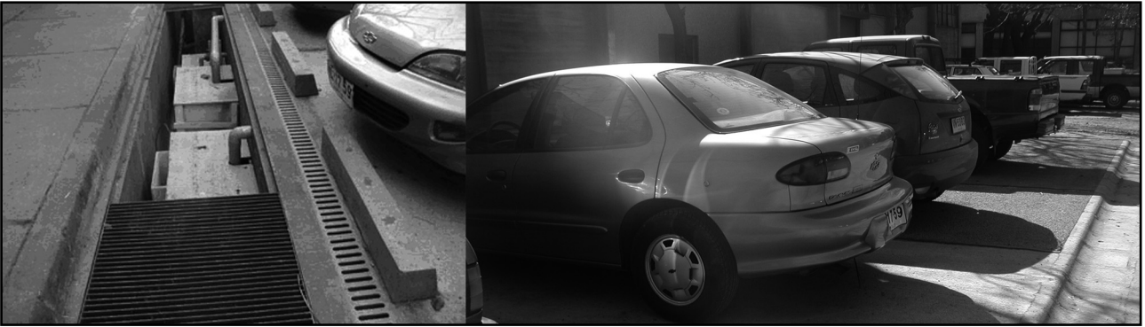
Figura 7. Instalación instrumentalizada de pavimentos porosos de hormigón. Figure 7. Porous concrete pavement test parking lot.
