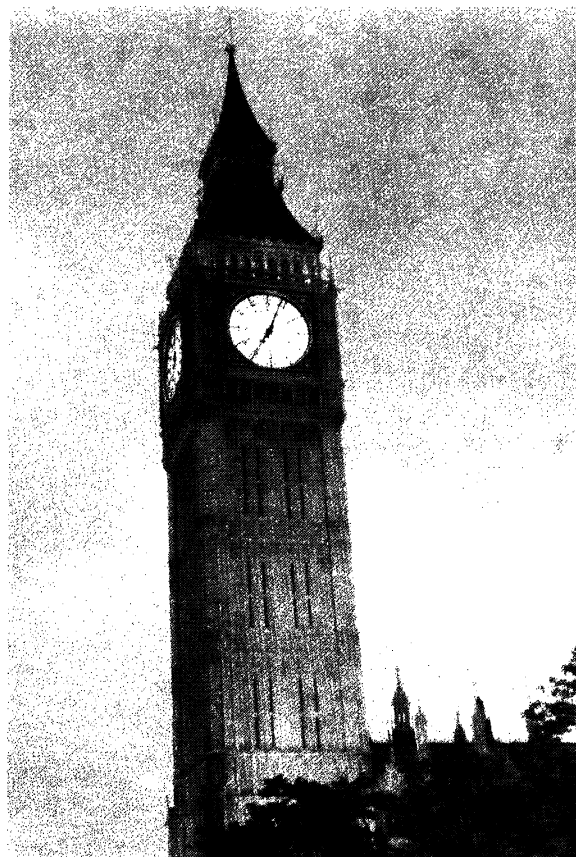
Foto 4.—"Piedra de Caén", caliza oolítica del batoniense. Torre del parlamento Británico.
