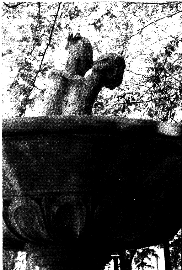
Foto 9.—Procesos de karstificación en una fuente del Paseo del Prado por efecto de la contaminación urbana.
