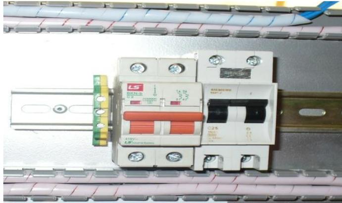
**Figura 3.8:** Ubicación de los dispositivos de protección en el riel DIN
