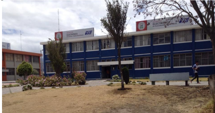
Figura 5. Fachada frontal del modular de Ingeniería Electrónica
