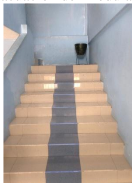
Figura 13. Escalera de evacuación del modular de Ingeniería Electrónica
