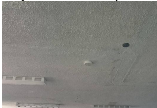
Figura 40. Detector de humo tipo iónico
