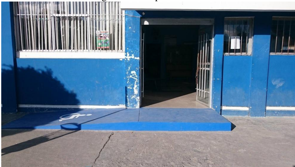
Figura 38. Rampa de acceso
