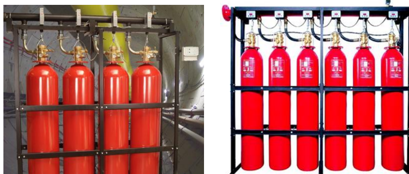
Figura 22. Extintores fijos
