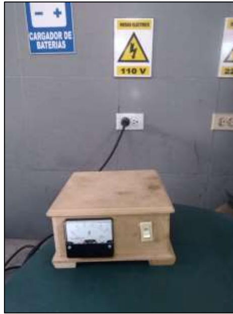
Figura 34-3: Conexión del cargador a tomacorriente de 110 voltios
