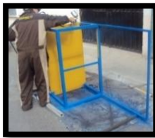
Figura 71. Pintando las estructuras
