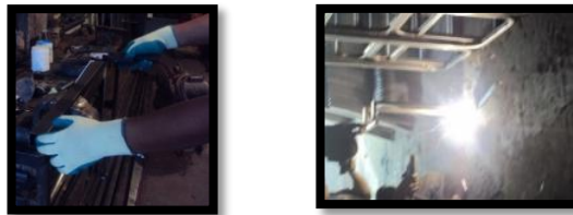
Figura 68. Soldando los elementos estructurales
