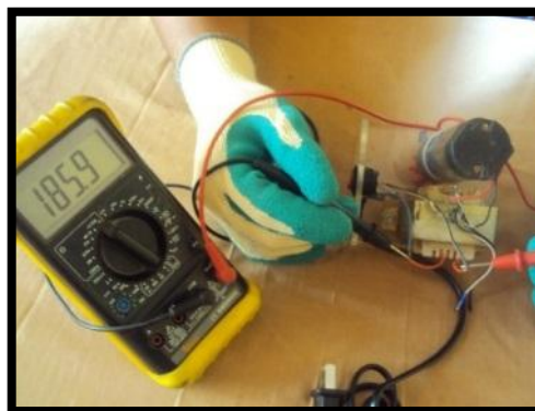
Figura 84. Comprobando continuidad a la entrada del transformador
