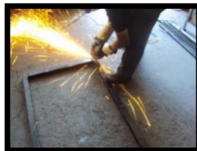
Figura 69. Puliendo las esquinas soldadas
