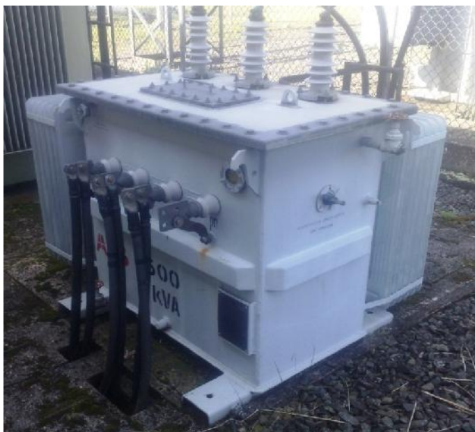
Figura 3.21. Transformador de 500 kV.
