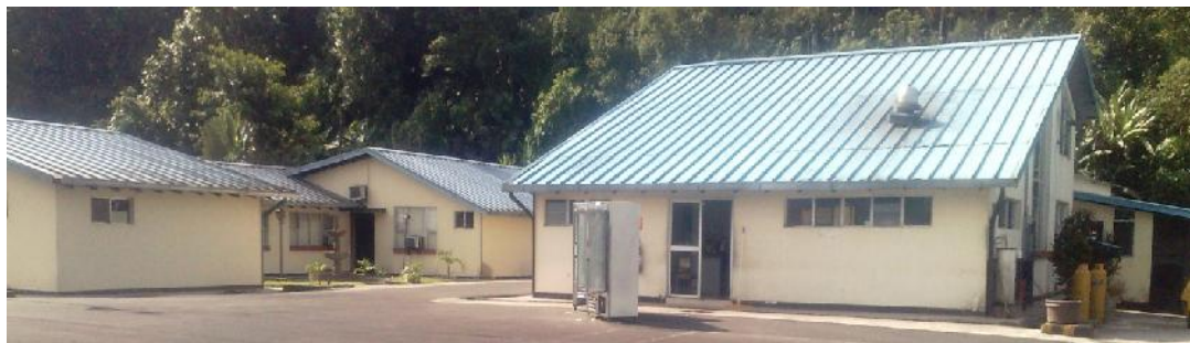
Figura 3.11. Habitaciones del personal de turno, cocina y comedor.
