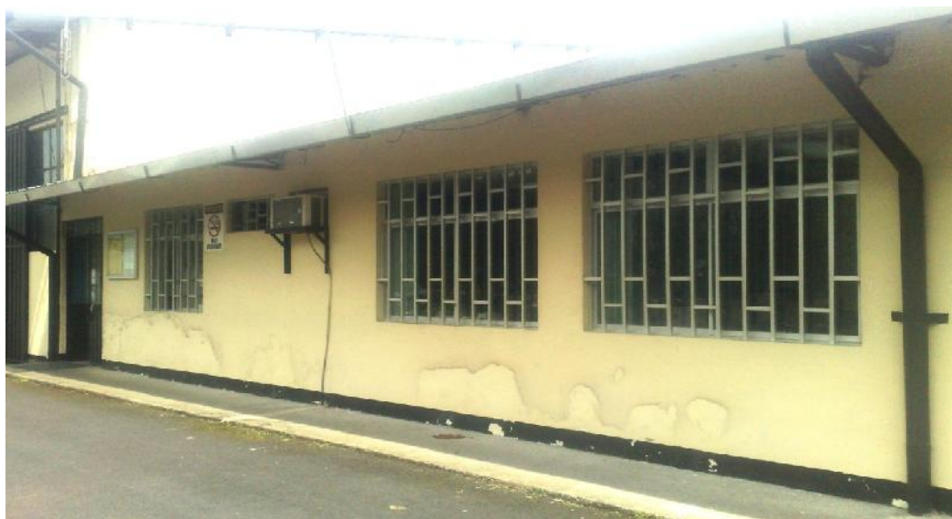
Figura 3.7. Bodega central de la estación.
