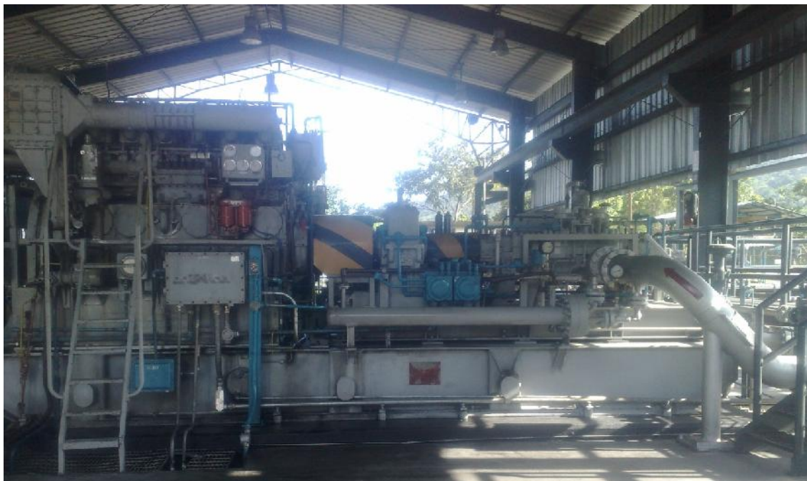
Figura 3.14. Motor de combustión Interna que acciona la bomba multietapa P-203.
