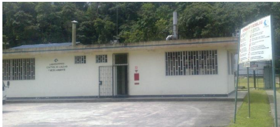
Figura 3.8. Laboratorio de control de calidad y ambiente.
