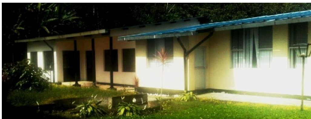
Figura 3.9. Gimnasio y habitaciones del personal de SIHAMA.
