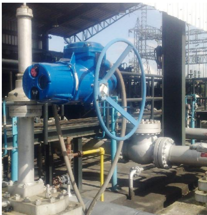
Figura 3.17. Actuador Limitorque, regulado de forma manual y por señales eléctricas.
