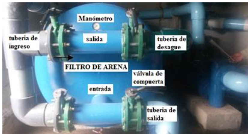
Figura 16-3. Sentido del agua durante el retrolavado.
