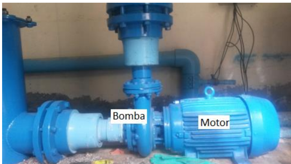
Figura 6-3. Bomba y motor conectados a continuación de la trampa de pelos.
