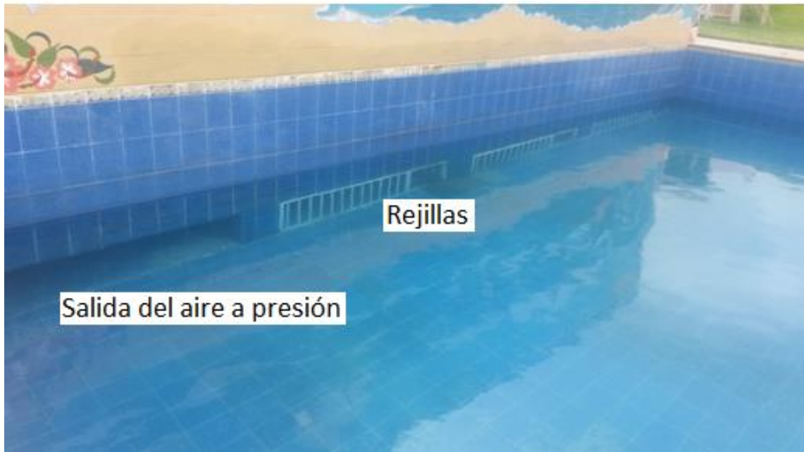
Figura 4-3. Piscina de olas se puede ver las rejillas ductos de salida del aire presión.
