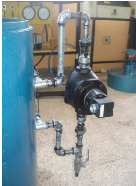
Figura 4.15: Instalación del McDonnell.
