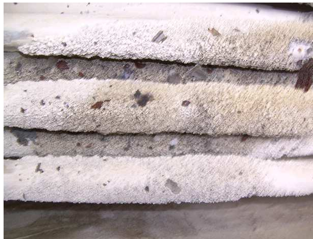
Figura 6.4: Incrustaciones en los tubos de fuego.
