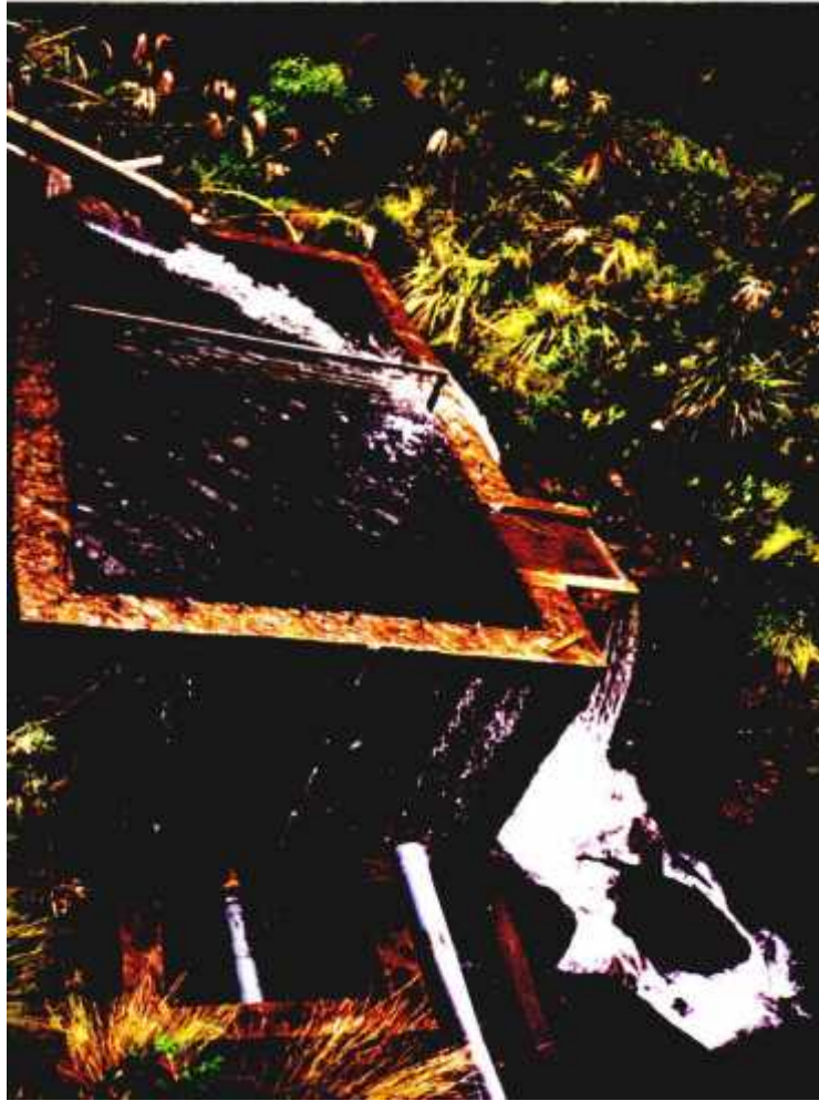
FIGURA 3.1. TANQUE ROMPE PRESION.
