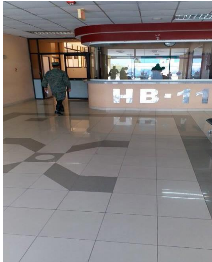
Figura 11-3: Piso de porcelanato en todo el hospital
