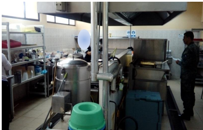
Figura 39-3: Cocina del HB 11 BCB “Galápagos”.
