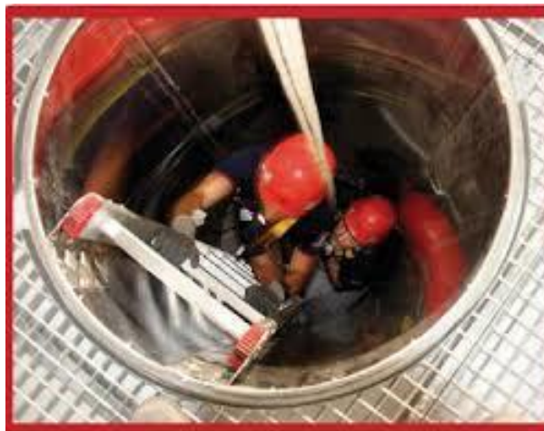
Figura 19-2: Trabajo en espacio confinado
