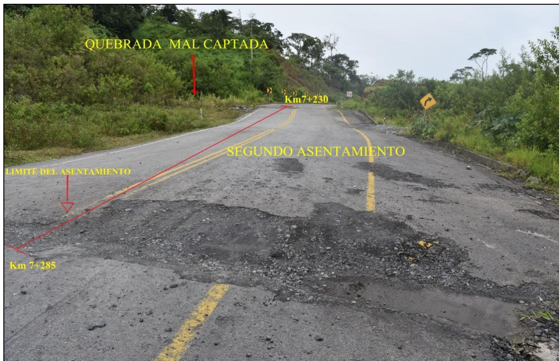
Figura 29-3 Segundo asentamiento ubicado entre las abscisas 7+230 – 7+285
