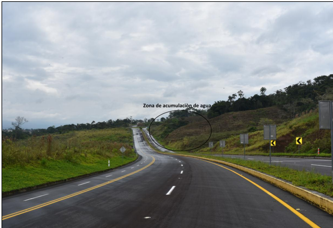
Figura 22-3 Acumulación de agua, abscisas 5+100 – 5+300 3.9 Modelo Geológico
