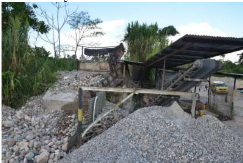
Figura3. Cantera de la constructora
