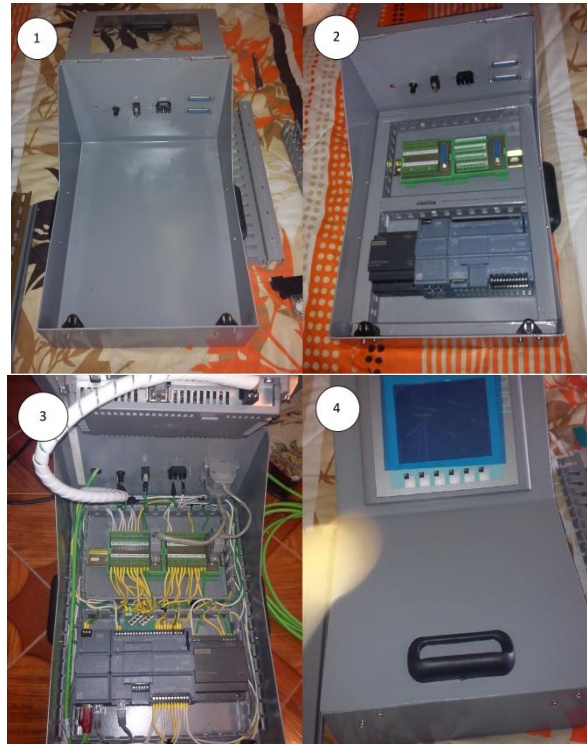
Figura 35. Etapas de montaje de la caja de equipos
