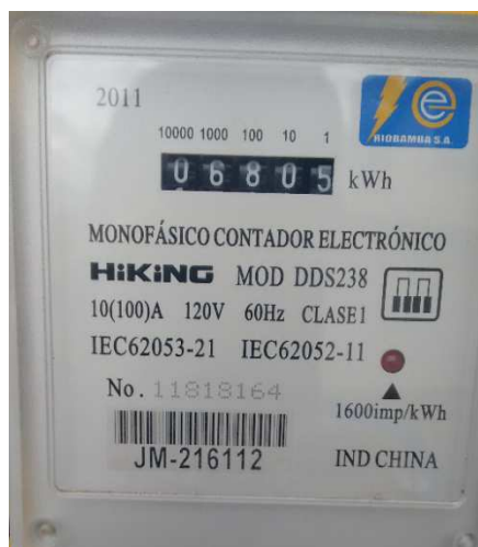
Figura 2-3 Medidor de Energía Eléctrica Hiking Realizado por: Arias Janeth, 2016
