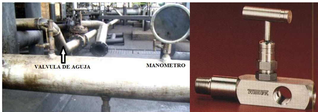
Figura 38: Manómetro, Válvula de Aguja (Presión de succión)
