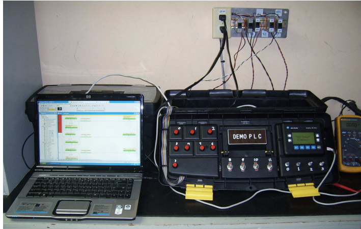
Figura 92: Instalación PLC DEMO
