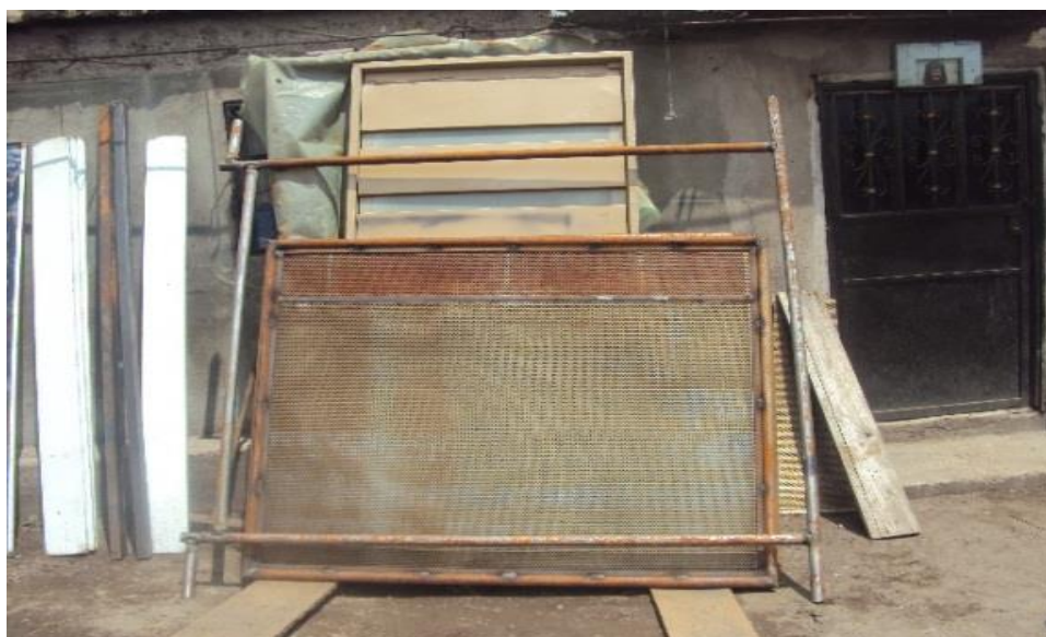
Gráfico 12. Construcción del marco para la malla de estacado.
