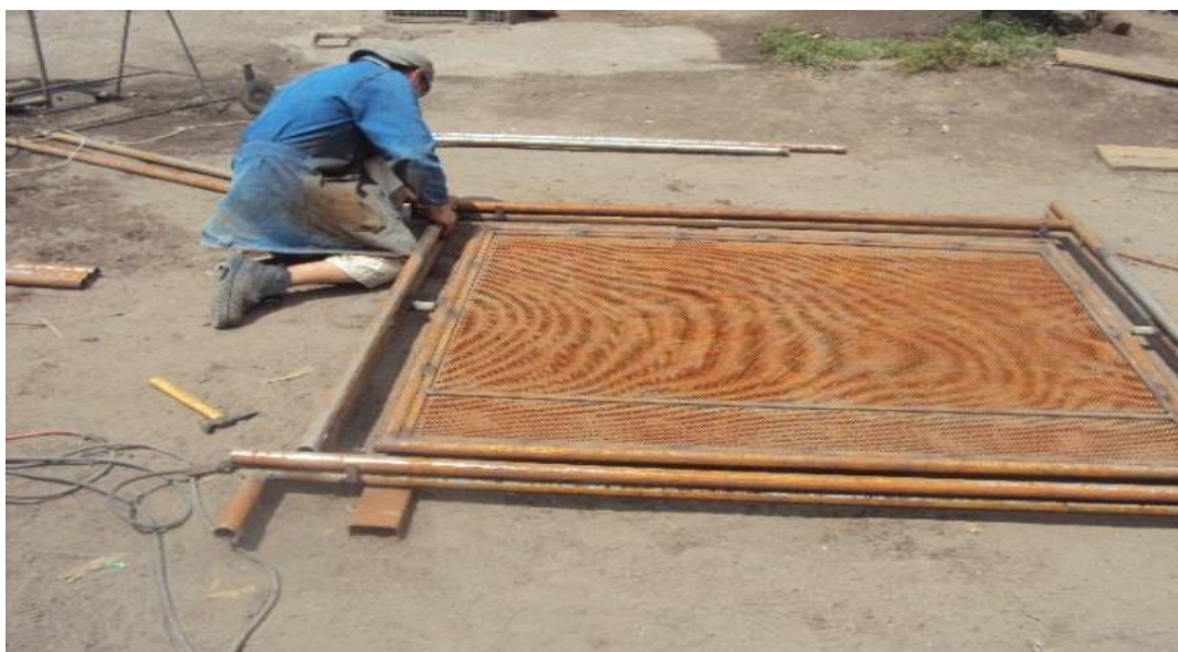
Gráfico 11. Construcción de la malla de estacado.
