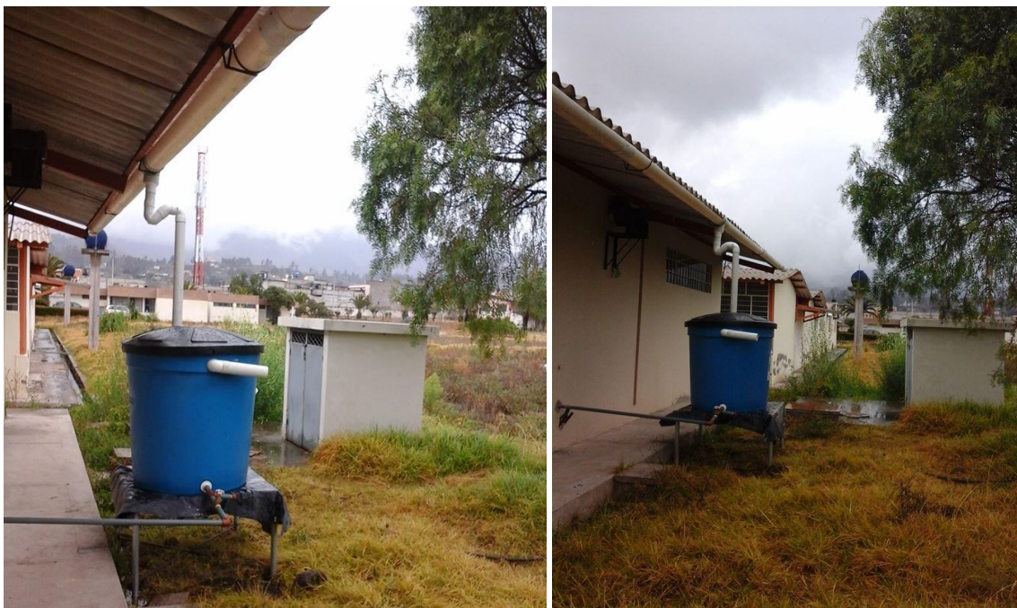
FOTOGRAFÍA 8: Sistema de conducción, almacenamiento y distribución en un día de lluvia
