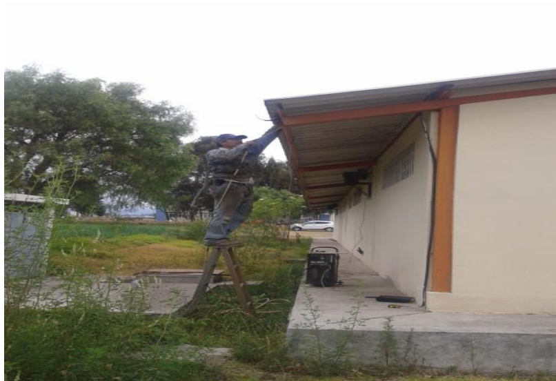
FOTOGRAFÍA 2: Soldadura de abrazaderas
