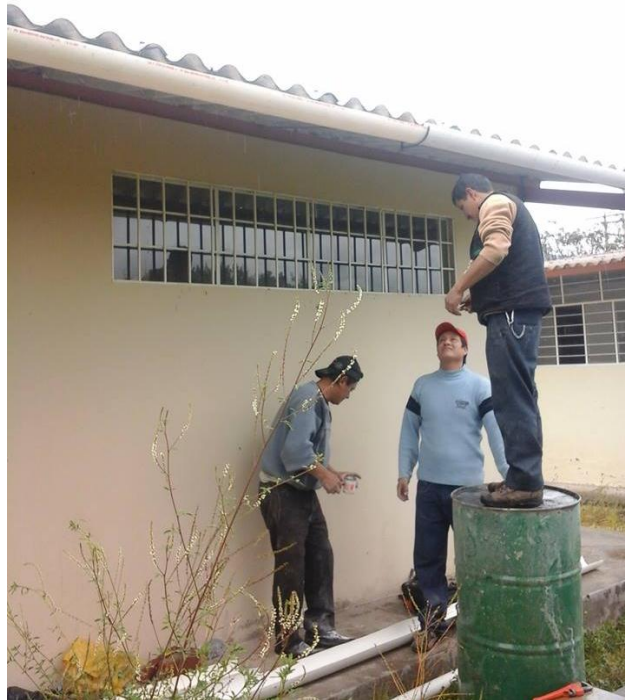
FOTOGRAFÍA 4: Colocación de las canaletas
