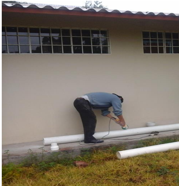
FOTOGRAFÍA 3: Preparación de las canaletas
