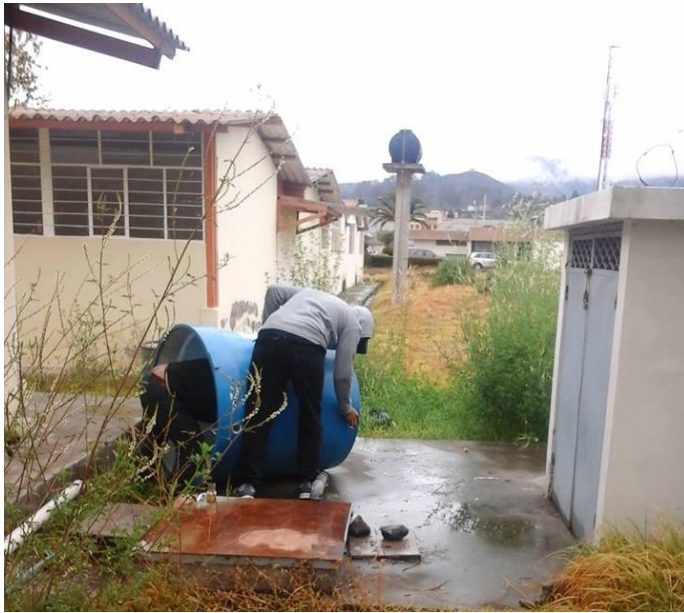
FOTOGRAFÍA 5: Limpieza y Adecuación del tanque de almacenamiento
