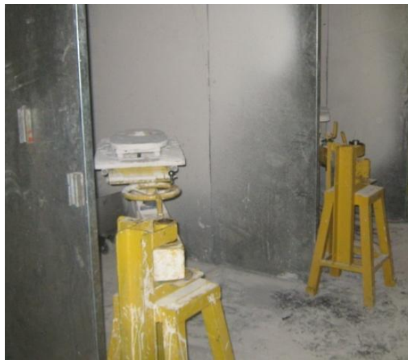
Figura 55: Instalación provisional de los brazos de esmaltado.
