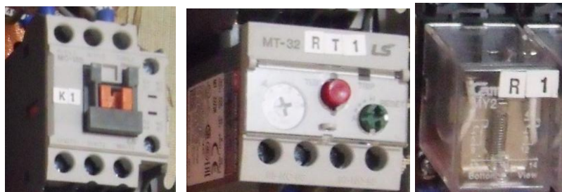
Figura 21-2: Contactor de 18A, relé térmico de 12 a 18A y relé de 10A.
