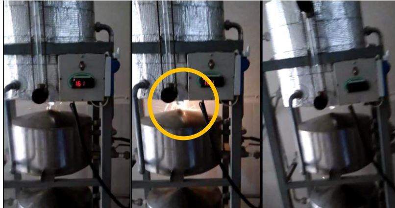
Figura 12-2: Cortocircuito provocado por el desbordamiento de agua
