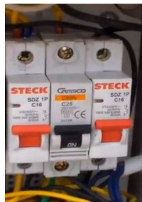
Figura IV.33. Interruptores Termomagnéticos 41
