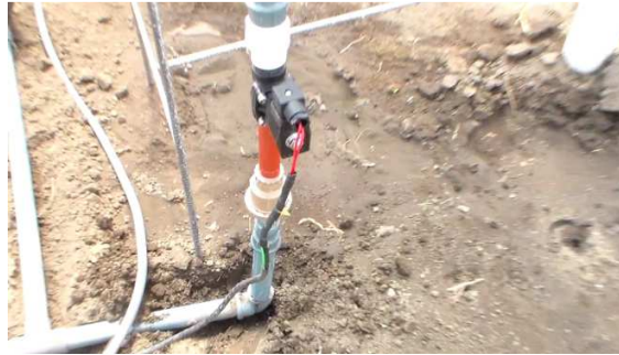
Figura8. Electroválvula del sistema 1
