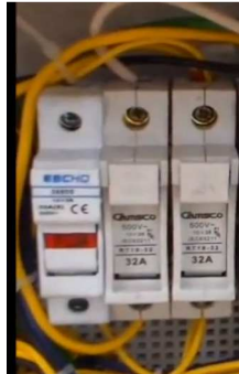
Figura IV.32. Fusibles tablero de control 40
