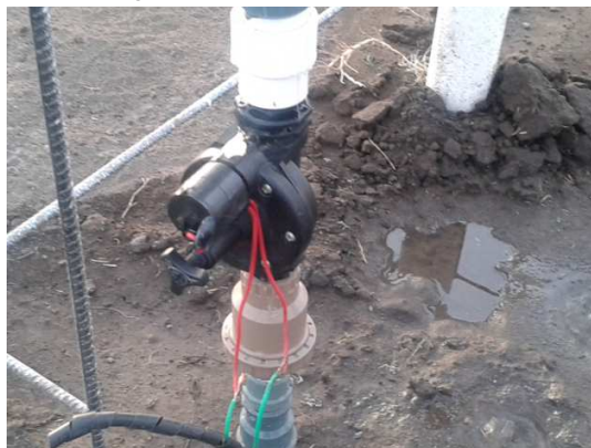
Figura9. Electroválvula del sistema 2
