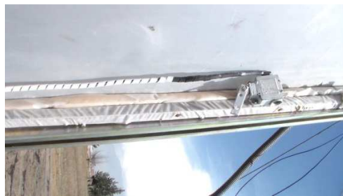
Figura13. Final de carrera superior NO
