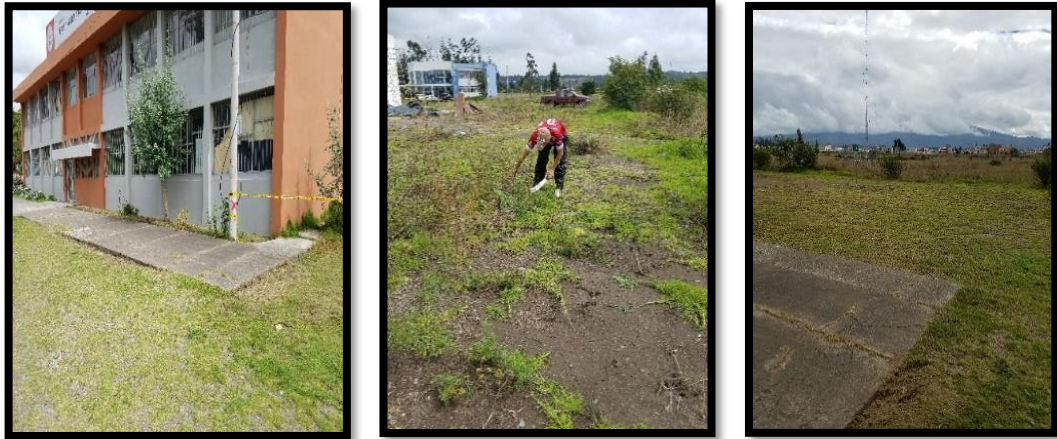
Figura 4.7. Adecuación del punto de encuentro instalado en la Escuela
