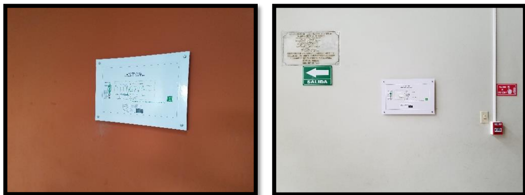
Figura 4.8. Mapas de evacuación instalados en la Escuela
