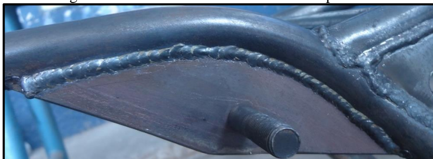
Figura 104. Cordón de soldadura refuerzo posterior.
