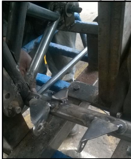
Figura 98. Guías de descanzador principal y apoyos de motor
