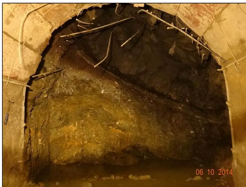
**Fotografía 11:** Contacto entre el depósito de ladera y lavas (Calidad Tipo V)
