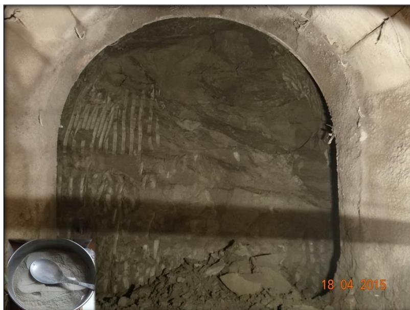
**Fotografía 14:** Depósito de arcilla, limo y arena (Calidad Tipo V)
