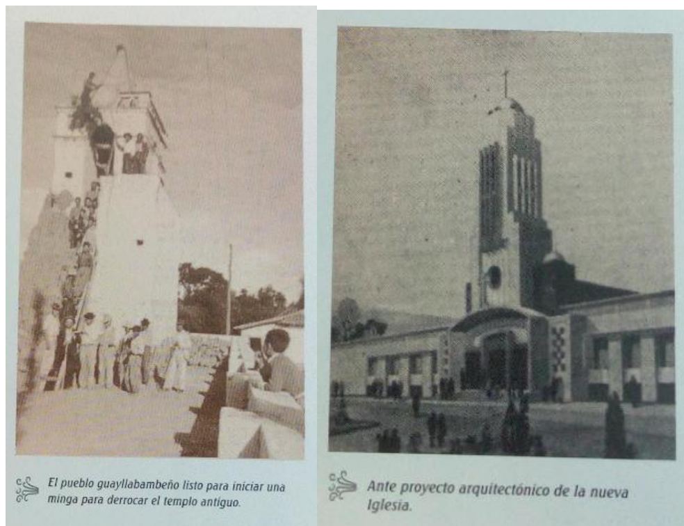
Figura 1-4 Derrocamiento de templo y ante proyecto arquitectónico
