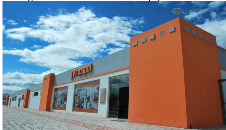
Figura 4. Edificio estructural Inpapel Cía. Ltda.
