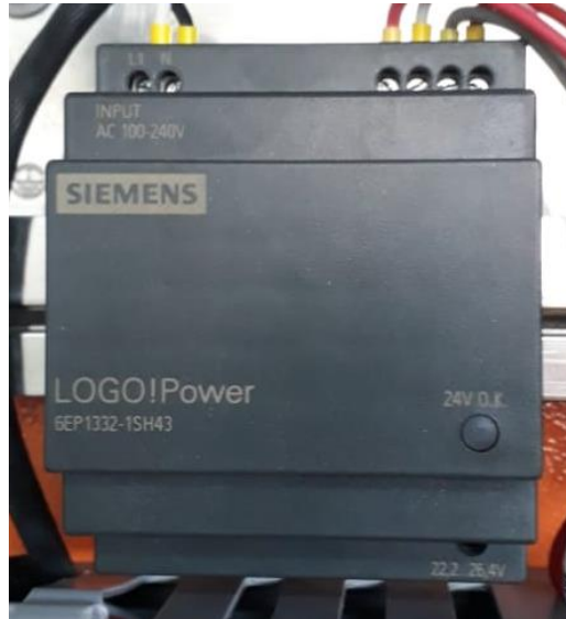
Figura 3-8: Fuente de alimentación SIEMENS 24 VCC 3A Fuente: Autores 2019
