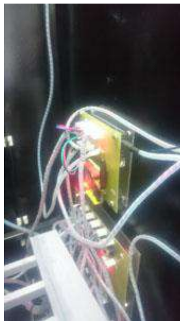
Figura 41-2: Montaje de las placas
