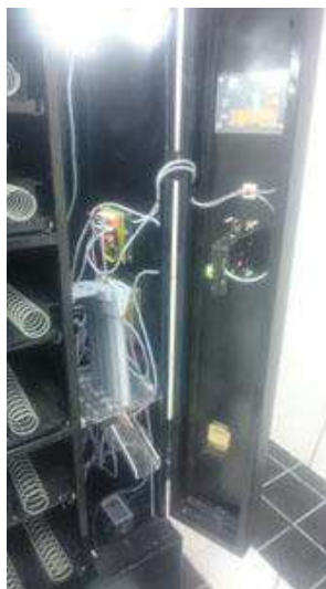
Figura 44-2: Colocación de bandejas y conexión de los dispositivos
