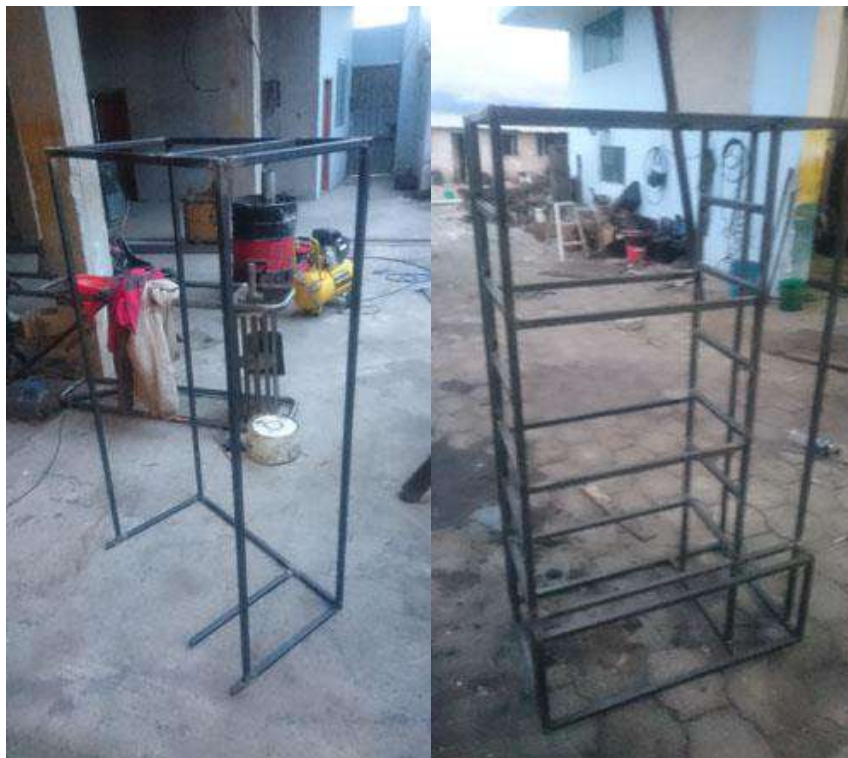
Figura 36-2: Construcción de la estructura externa e interna
