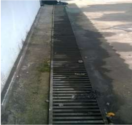
Canal de desagüe
