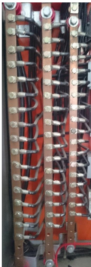
Figura 8-2 Barra de cobre de \frac{1}{4} x \frac{1}{2} pulgadas Realizado por: Coronel, Boris; 2017
