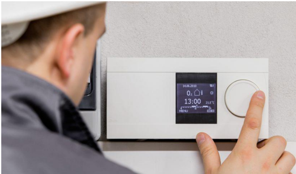
Figura 7-2: Control de temperatura.
