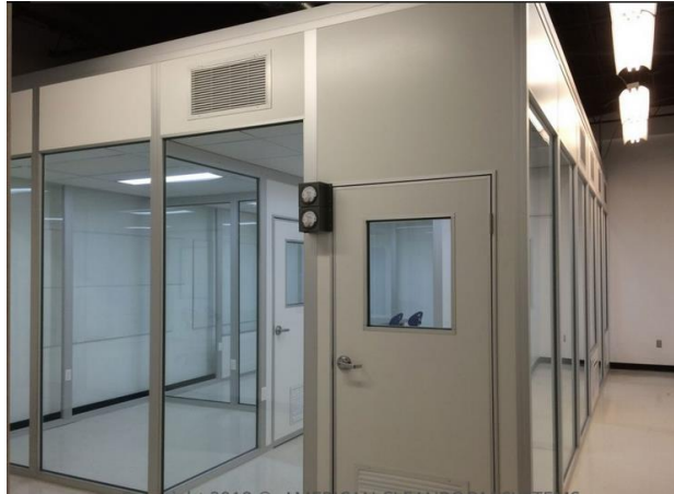
Figura 3-2: Cuarto limpio modular de paredes rígidas.
