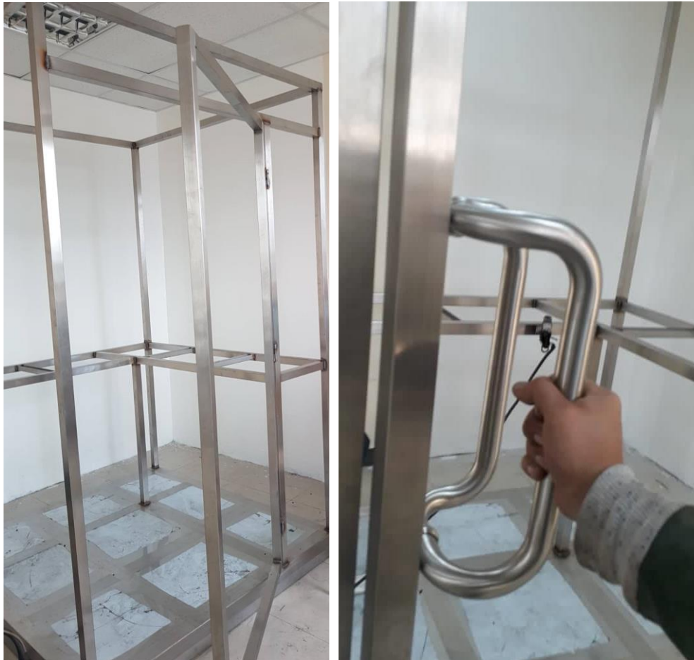
Figura 48-3: Elaboración puerta de la cabina.
