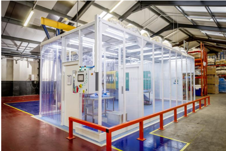
Figura 18-3: Cuarto Limpio de Paredes Blandas
