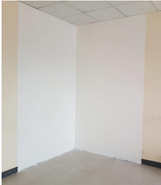
Figura 49-3: Adecuación de paredes del laboratorio.
