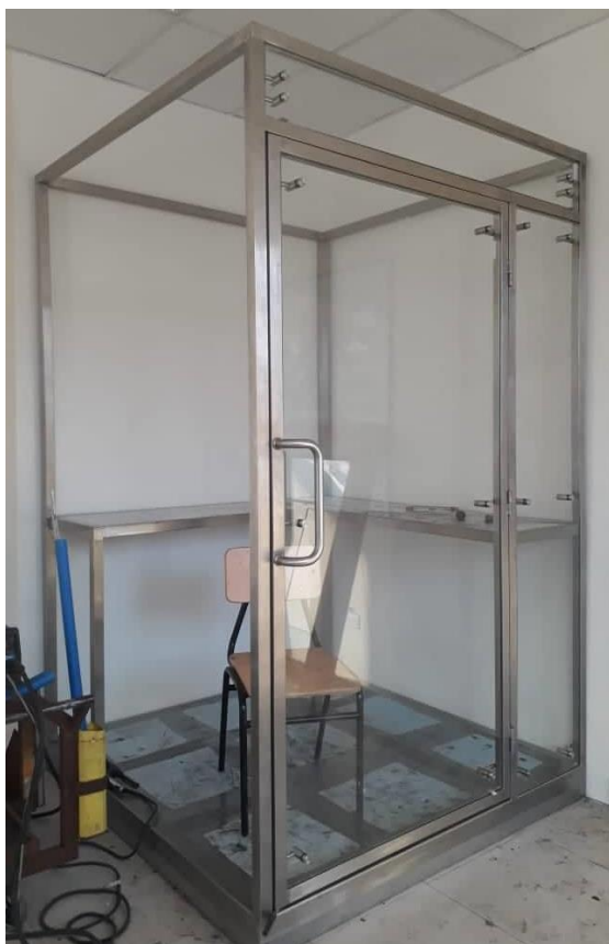
Figura 50-3: Montaje paredes de vidrio.
