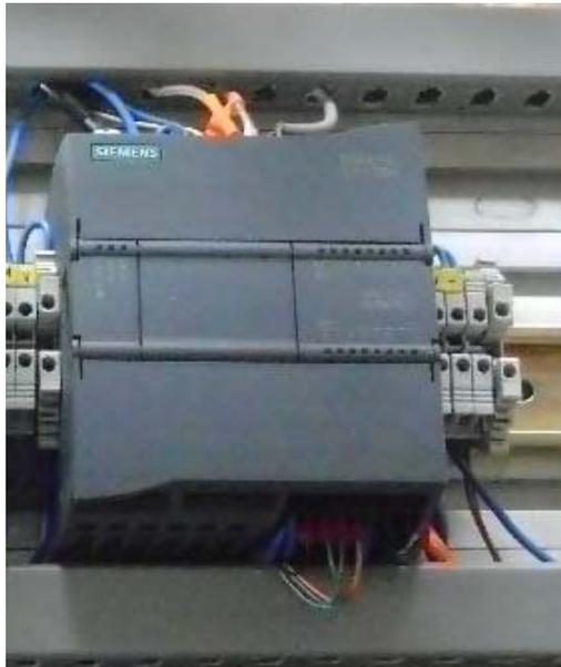
*Figura. VI.97. Conexión de Entradas y Salidas al PLC*
