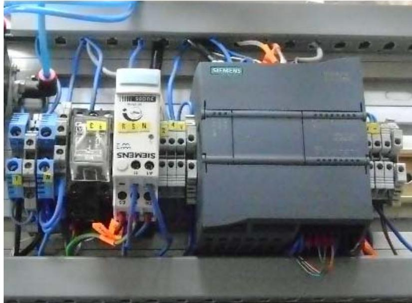
*Figura. VI-98 Conexión de sensores y actuadores a las borneras*
