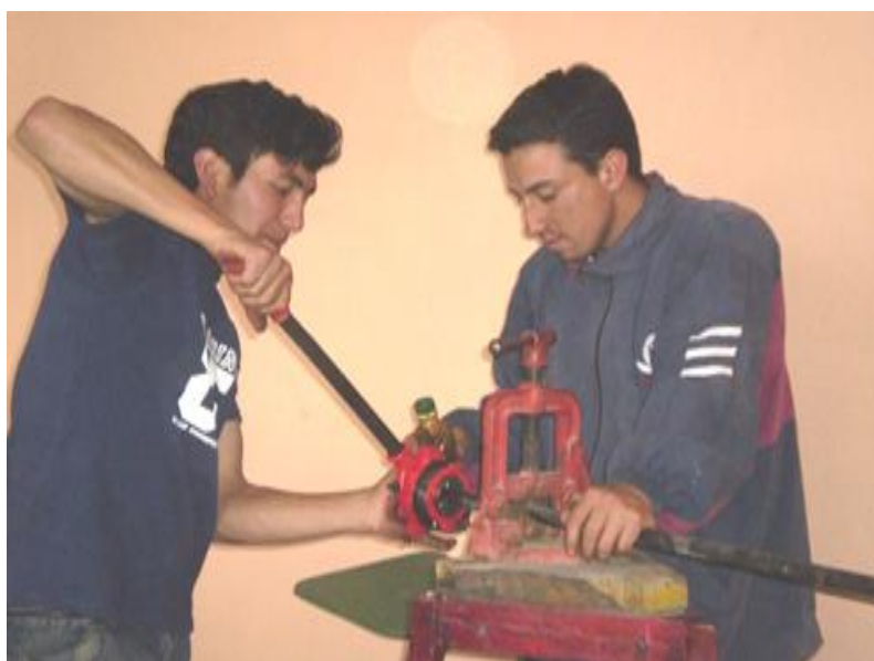
Fig. 28 Roscado de la tubería
