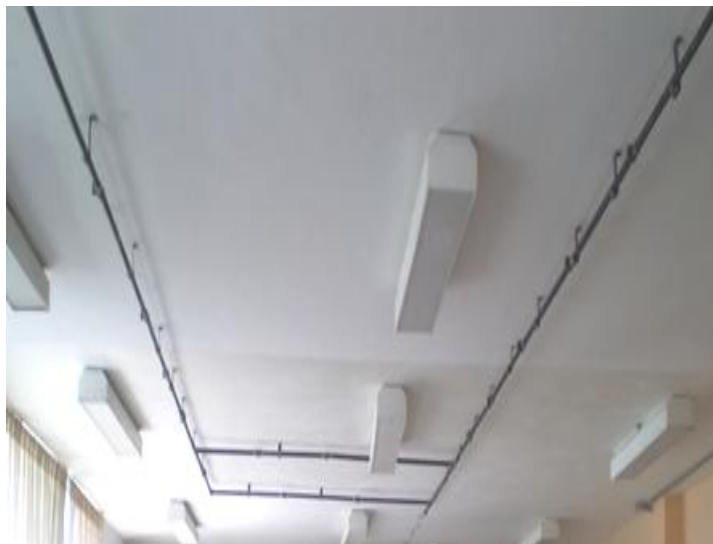
Fig. 29 Montaje del anillo de la red
