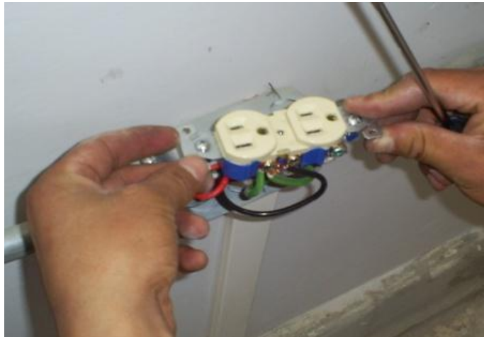
Fig. 21 Instalación tomacorrientes
