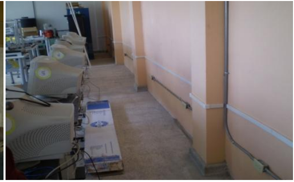
Fig. 37 Canaletas instaladas
