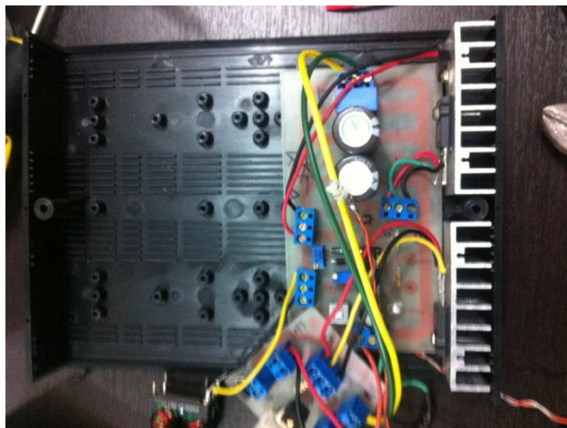
Figura 73. Instalación de elementos electrónicos
