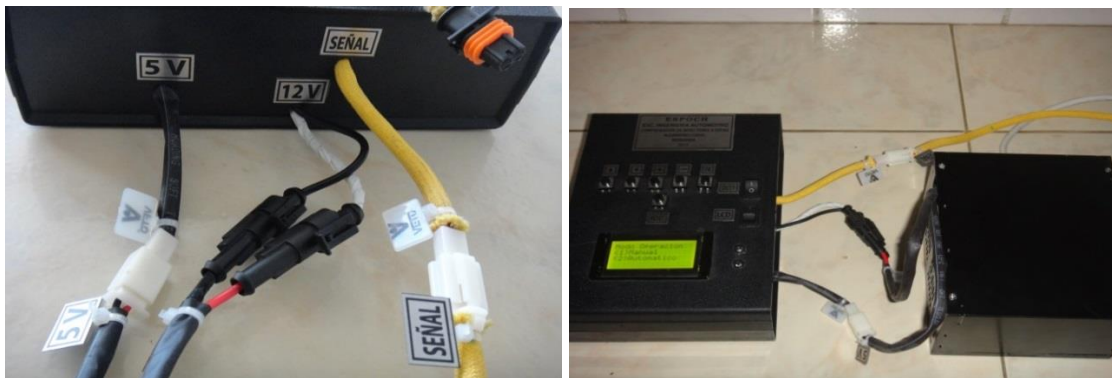
Figura 80. Conexión cables de voltaje y señal
