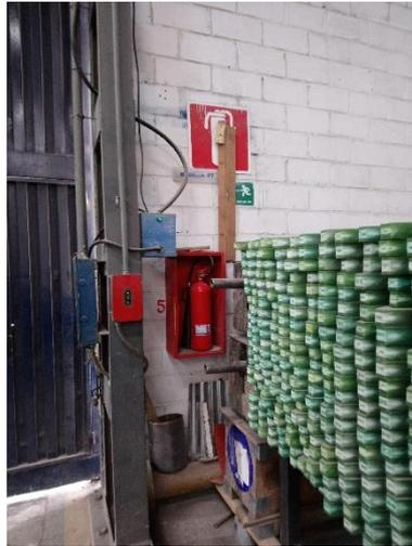
**Figura 43-3.** Extintor obstaculizado de la línea TECHO LUZ
