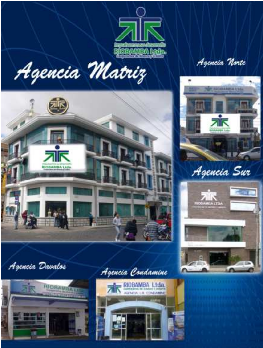
FIGURA No.23 Interna
