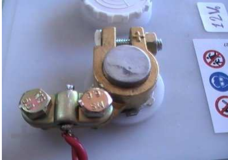
Figura 6.20 Instalación de cables en borne de la batería
