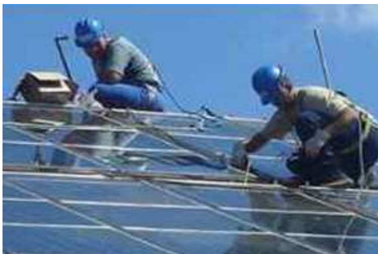
Figura 6.18 Instalación de un sistema fotovoltaico con seguridad
