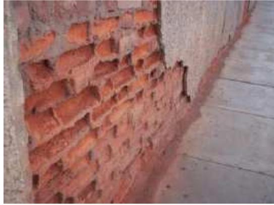
**Figura 2.8 Ladrillos deficientes**
