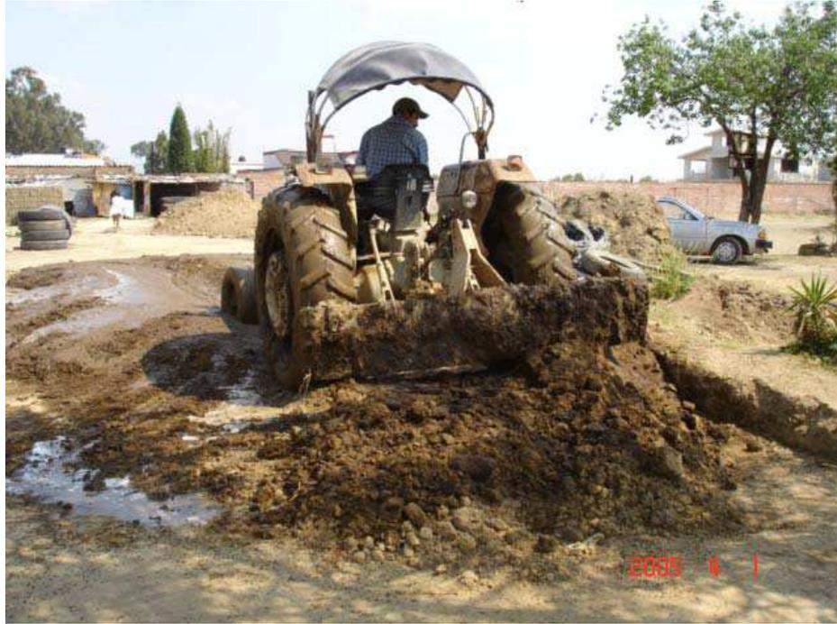
**Figura 2.3** Tractor agrícola para la elaboración de la mezcla.
