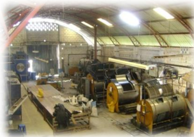
Figura 16. Inexistencia de rutas de circulación
