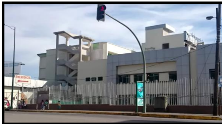
Fotografía 1-2: Fachada frontal del Hospital José Mará Velasco Ibarra de Tena
