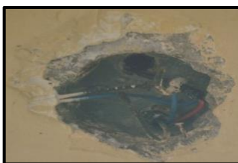
Figura 20. Sistema Eléctrico Municipal de Chambo
