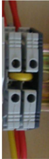
*Fig. III. 6 Borneras De Conexión LOGO! 230RC*
