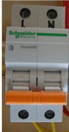
*Fig. II. 12 Relé Termomagnético*
