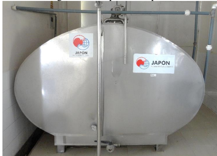
Figura 17. Tanque de recepción
