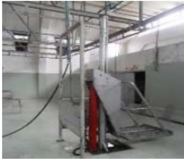
Figura 7-2: Bomba multietapa para lavado de canal
