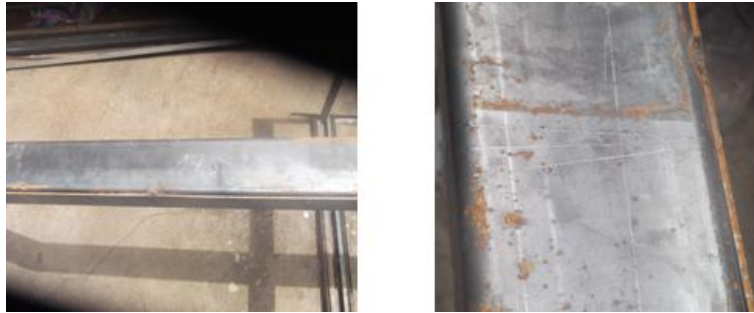
Figura 5.3. Medición y marcado del elemento estructural
