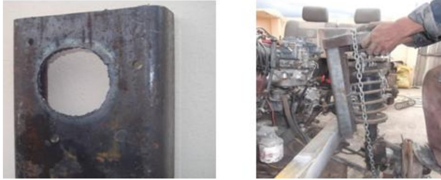
Figura 5.12. Montaje del sistema de suspensión delantero
