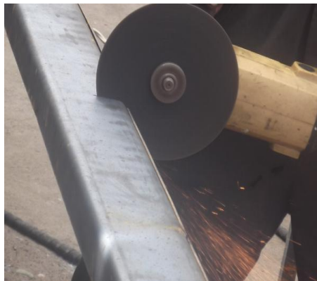
Figura 5.4. Cortado del elemento estructural
