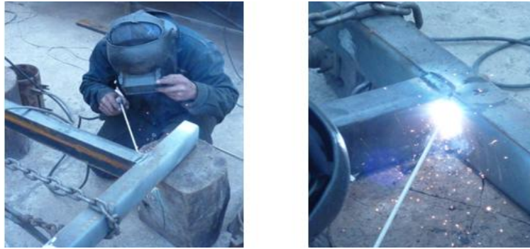
Figura 5.7. Soldadura de travesaños
