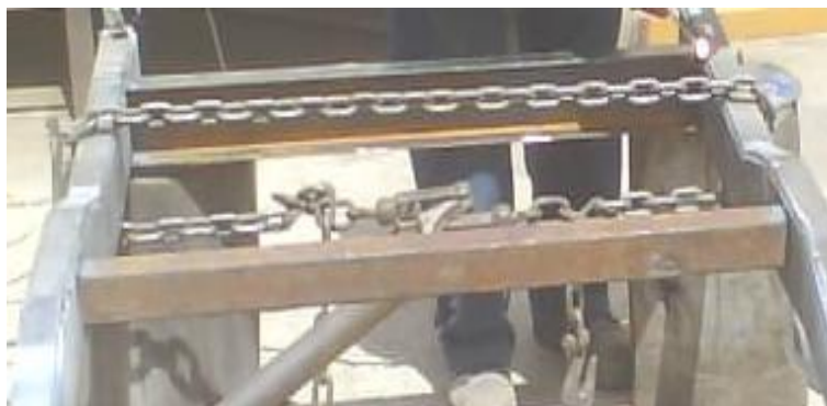
Figura 5.6. Encuadrado y nivelación del bastidor
