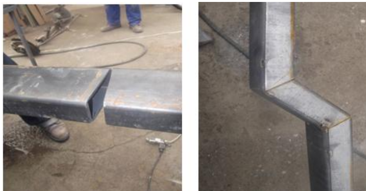
Figura 5.5. Corte a inglete y doblado del elemento estructural
